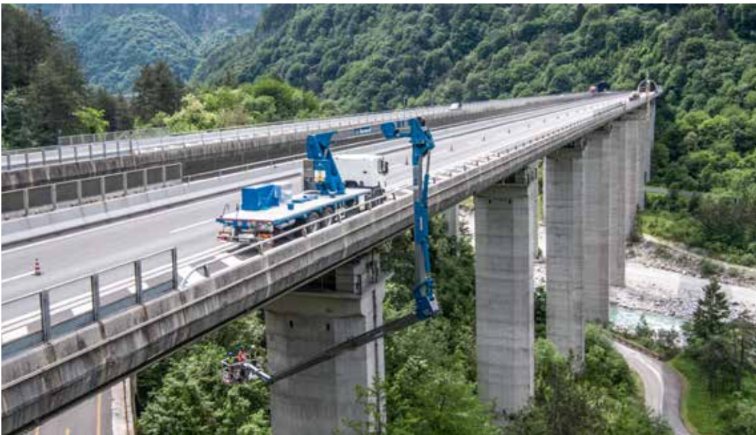
Bild 1: Safety first. Mobile Arbeitsbühnen für die Brückeninspektion müssen zur Sicherheit der Bediener immer einwandfrei funktionieren. Das Bild zeigt das BARIN Modell AB20S bei einem Einsatz auf der italienischen Autobahn A23. Bild: BARIN
