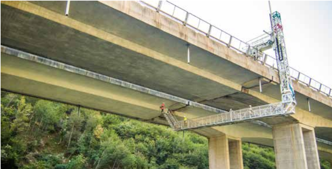
Bild 2: Brückeninspektion auf der italienischen A27, in diesem Fall bei trockener Witterung. Die mobilen Maschinen sind aber oft Feuchtigkeit, Salz und großen Temperaturschwankungen ausgesetzt. Robustheit und Zuverlässigkeit der Komponenten sind daher ein Muss. Bild: BARIN
